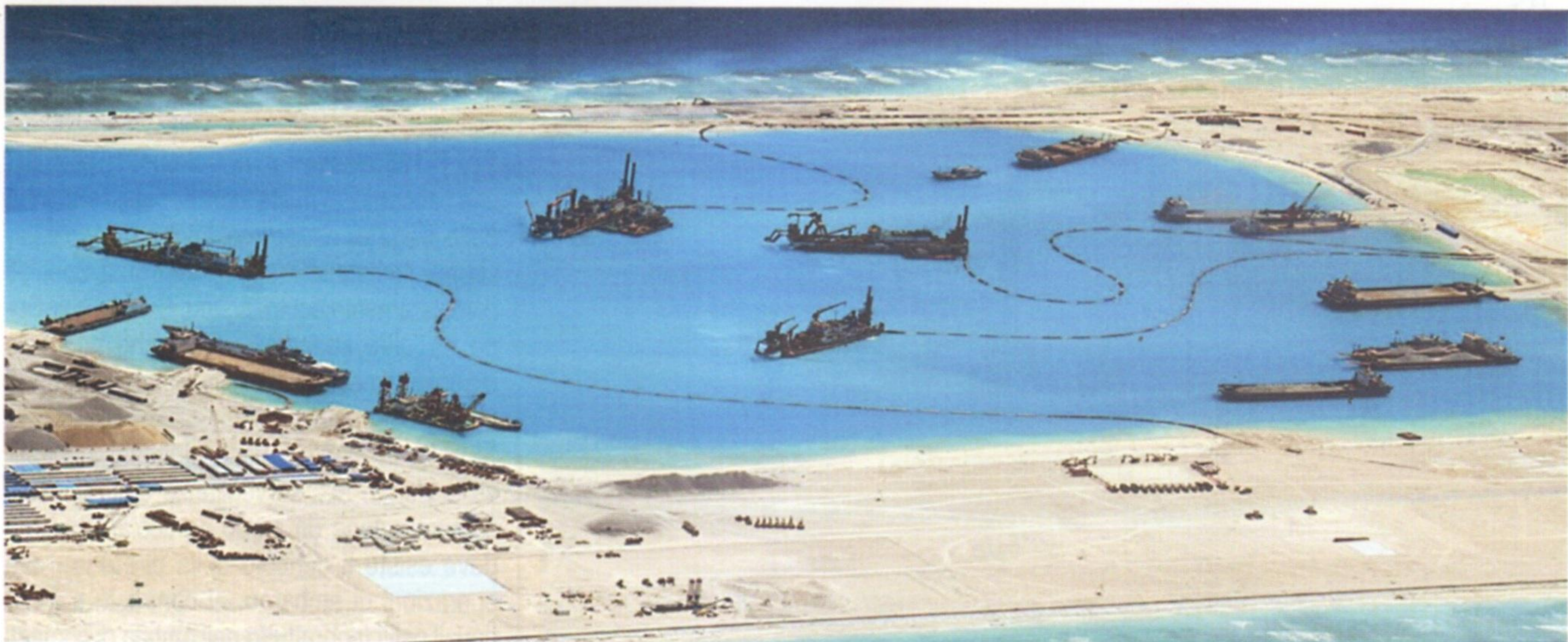
La costruzione di un'isola si basa sull'impiego di draghe che aspirano la sabbia dal fondo e la depositano sugli scogli, per ampliare e consolidare il territorio. Sulla sinistra è ben visibile una nave da sbarco classe YUTIN (Type 072).
