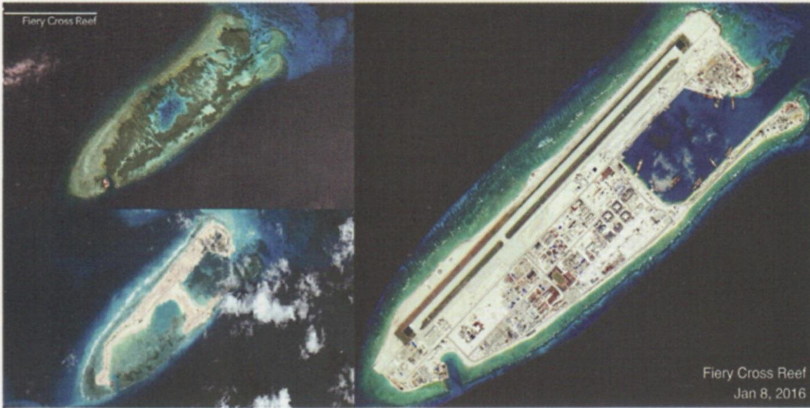
L'evoluzione del Fiery Cross Reef, da semplice atollo disabitato (2006) ai primi effetti della "land reclamation" (2008) fino al completamento dell'infrastruttura (2016).
